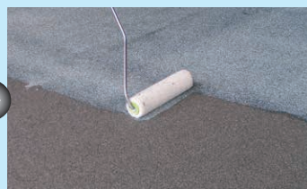
●プライマーの塗布
