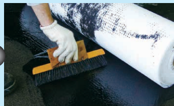
●ハルPCマットの流し張り
