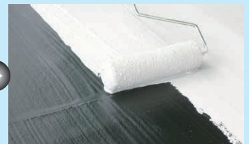
●保護層の施工
